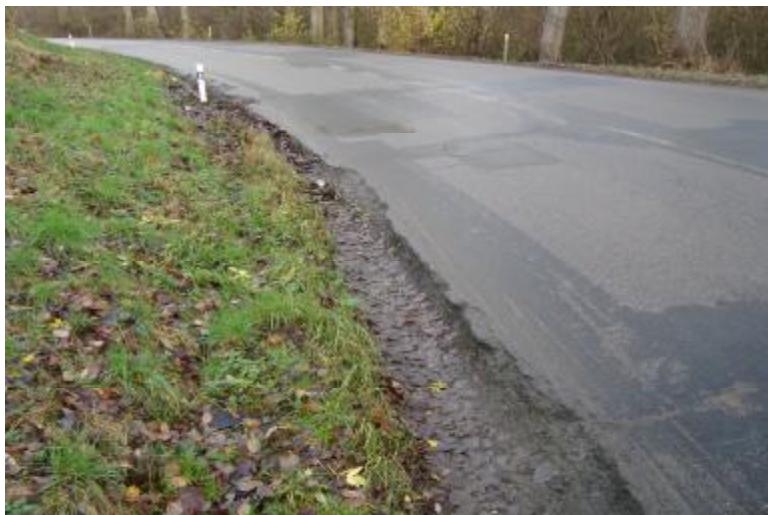
Obr. 04 Vymletá krajnice silnice v důsledku protékající vody km 123,51
