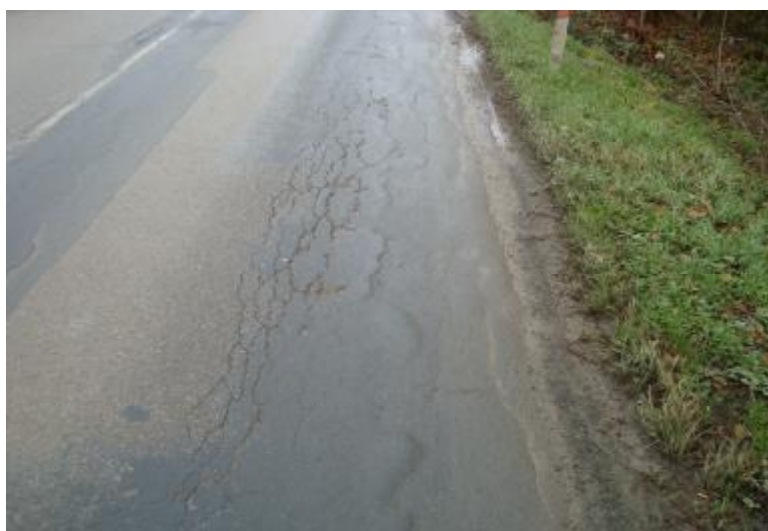
Obr. 06 Mozaikové až síťové trhliny, příčné a podélné rozvětvené trhliny na okraji vozovky
