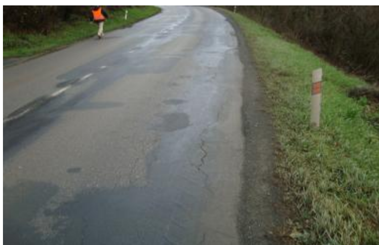
Obr. 05 Podélné rozvětvené trhliny na okraji vozovky
