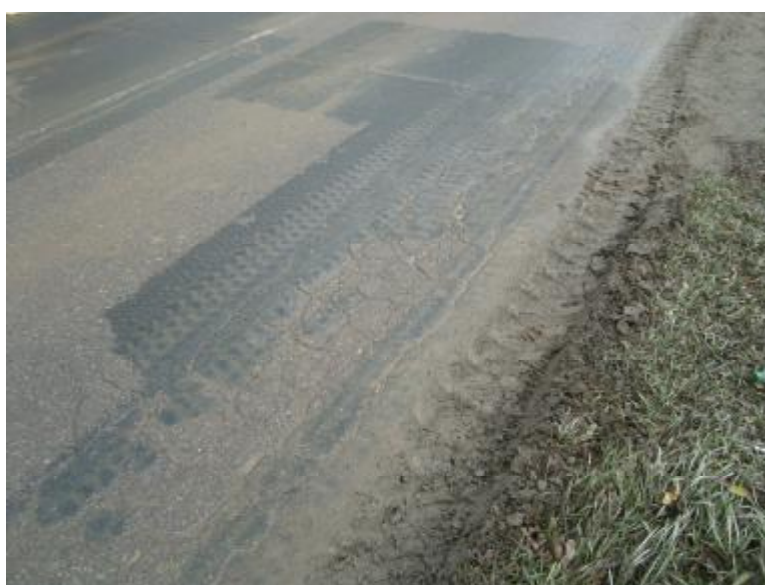
Obr. 09 Mozaikové až síťové trhliny, příčné a podélné rozvětvené trhliny na okraji vozovky
